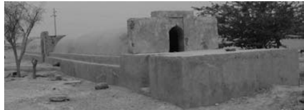
< نمونه دیگری از تغییراتی که در طول زمان ما شاهد آن بوده ایم ترکیب سقف طاق‌دیسی و سقف تخت است به گونه‌ای که مخزن این دو با دیواره ای از یکدیگر جدا بوده ولی از پایین با لوله‌هایی به هم متصل می‌شوند.
